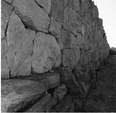
Εικ. 23. Λεπτομέρεια της θεμελίωσης
