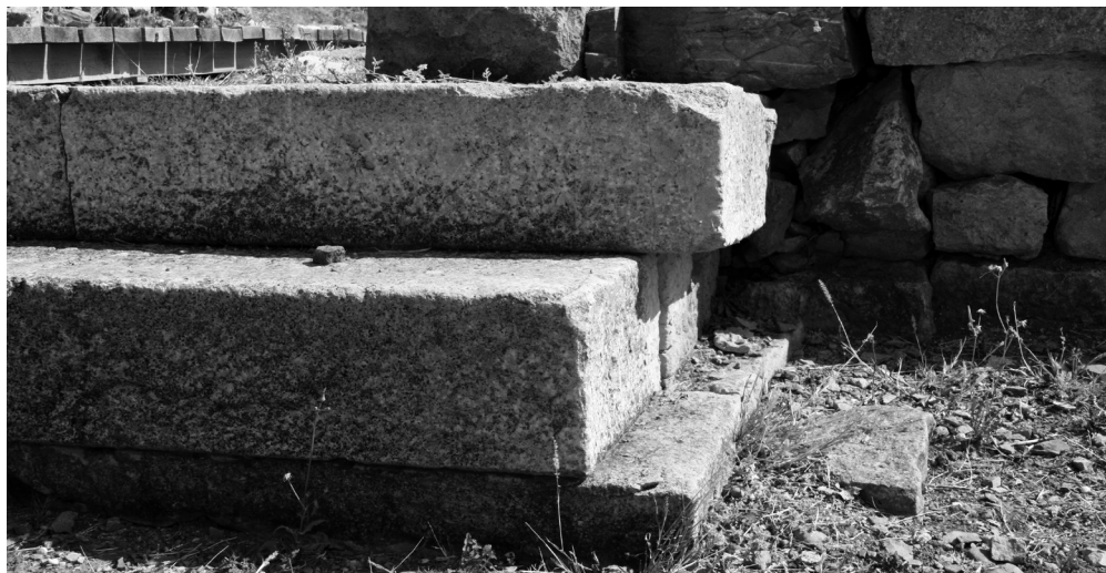
Εικ. 34. Λεπτομέρεια από τον τοιχοβάτη και το διβαθμιδωτό κρηπίδωμα
