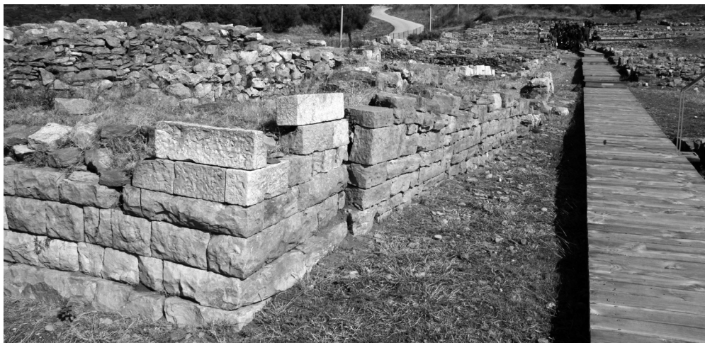
Εικ. 42. Μετατόπιση του ανατολικού τοίχου του Νέου Πύργου
