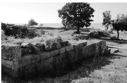
Εικ. 39. Η εξωτερική δυτική και βόρεια παρειά του Νέου Πύργου
