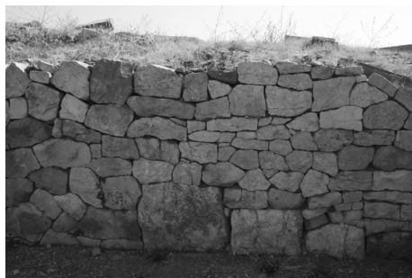
Εικ. 21. Λεπτομέρεια του λέσβιου συστήματος τοιχοδομίας στο δυτικό τείχος
