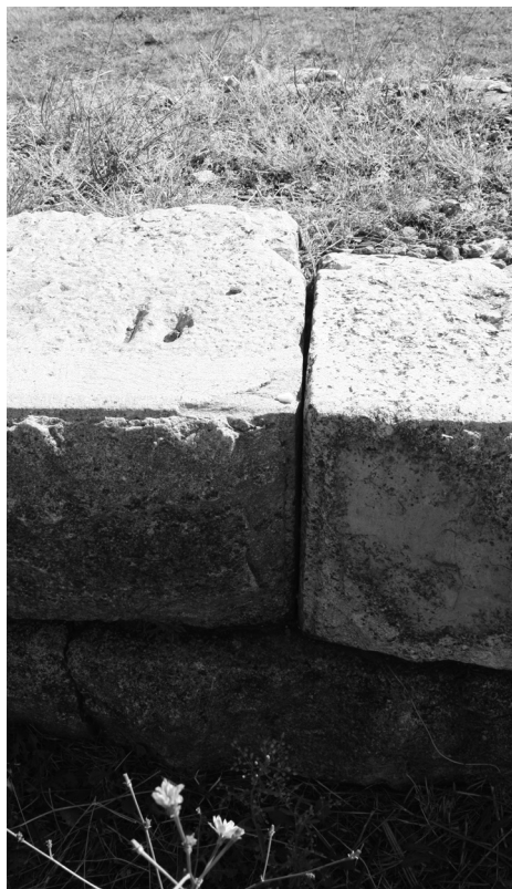
Εικ. 55. Ίχνη περιτένειας και μοχλοβοθρίων
