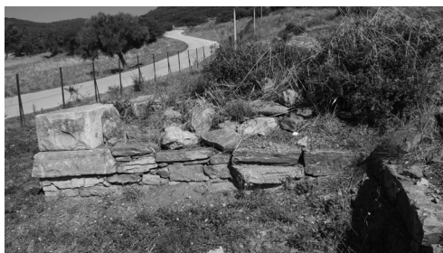
Εικ. 60. Η νότια πλευρά της πυργοειδούς κατασκευής
