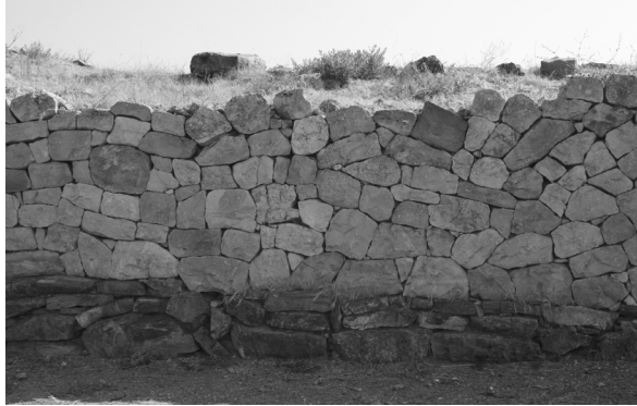
Εικ. 24. Η θεμελίωση του λέσβιου τμήματος του δυτικού τείχους
